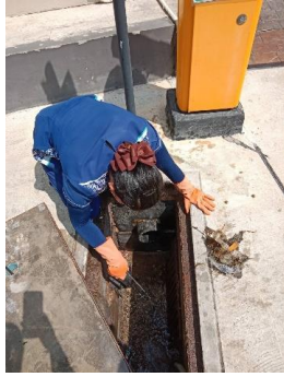
รูปที่ 25 การทำความสะอาดและตรวจสอบสิ่งอุดตันหรือ กีดขวางทางน้ำไหล
