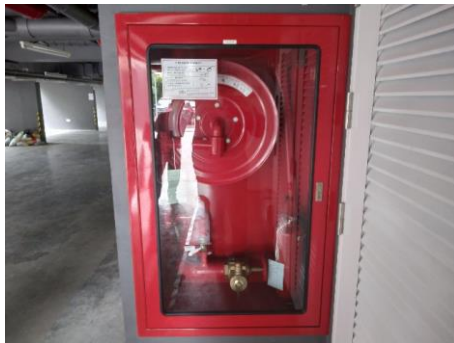
รูปที่ 25 การทำความสะอาดและตรวจสอบสิ่งอุดตันหรือ กีดขวางทางน้ำไหล
