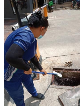
รูปที่ 26 ทำความสะอาดตะแกรงดักมูลฝอย
