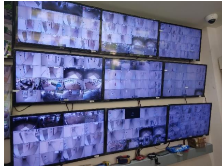
รูปที่ 33 ระบบโทรทัศน์วงจรปิด (CCTV System)
