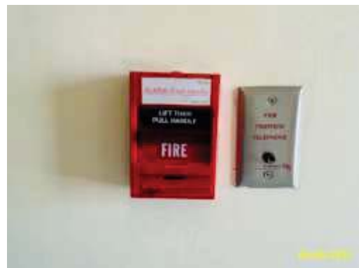
อุปกรณ์กดแจ้งเหตุและ Fire Telephone
