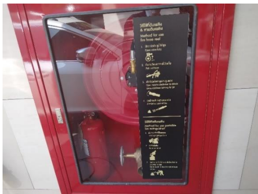
รูปที่ 19 ตู้เก็บอุปกรณ์ดับเพลิง พร้อมป้ายแนะนำวิธีการใช้อุปกรณ์ดับเพลิง
