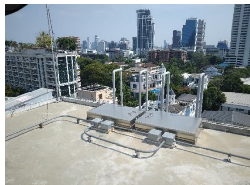
รูปที่ 8 ถังเก็บน้ำใต้ดิน และถังเก็บน้ำชั้นดาดฟ้า
