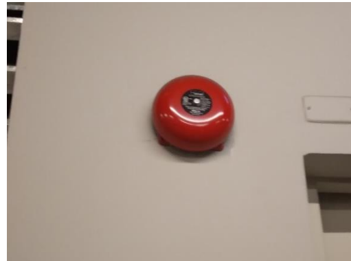
รูปที่ 18 อุปกรณ์ส่งเสียงสัญญาณแจ้งเหตุ
