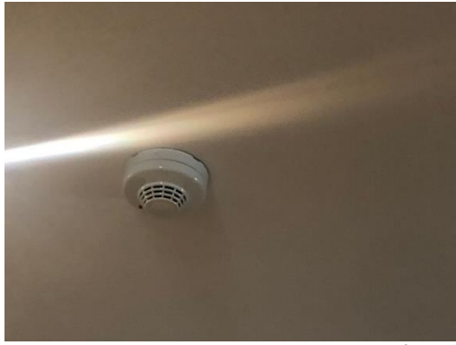
รูปที่ 16 เครื่องตรวจจับควัน
