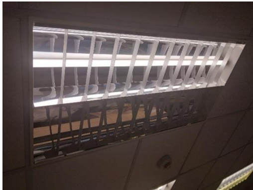
รูปที่ 39 โคมไฟแบบมีแผ่นสะท้อน
