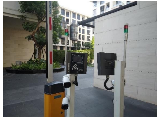
รูปที่ 30 ระบบคีย์การ์ดของลูกบ้าน (ที่จอดรถ)
