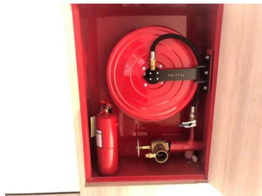
รูปที่ 19 ตู้เก็บอุปกรณ์ดับเพลิง พร้อมป้ายแนะนำวิธีการใช้อุปกรณ์ดับเพลิง
