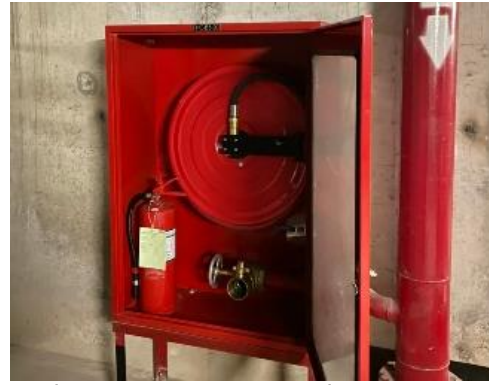
รูปที่ 28 ระบบดับเพลิงภายในที่จอดรถอัตโนมัติ
