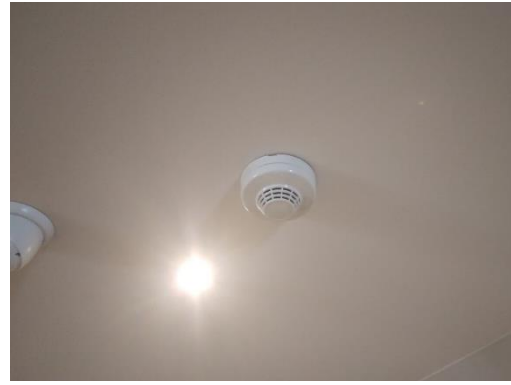
รูปที่ 16 เครื่องตรวจจับควัน
