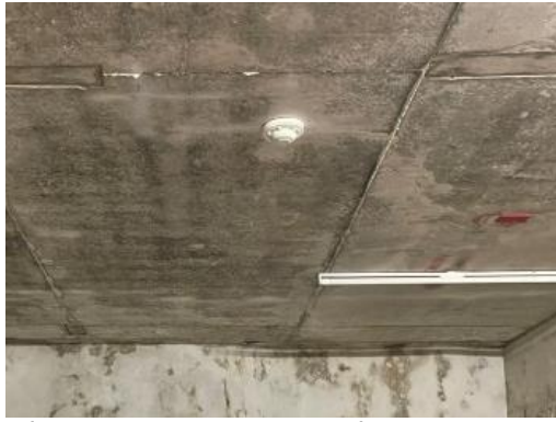
รูปที่ 27 ระบบ Gas Detector ในที่จอดรถยนต์อัตโนมัติ
