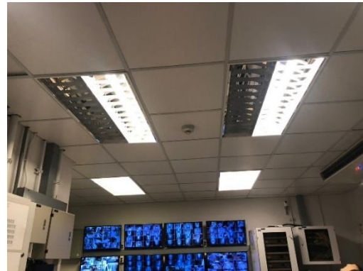
รูปที่ 39 โคมไฟแบบมีแผ่นสะท้อน
