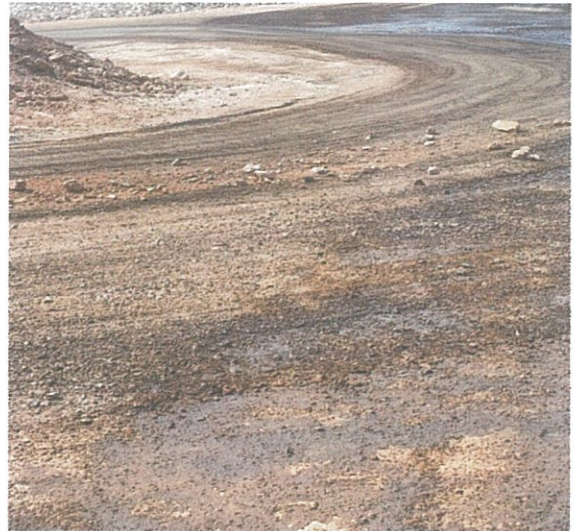
รูปที่ 2 ลาดผิวการจราจรด้วยวัสดุชั้นหนืดตามเส้นทาง จากหน้าเหมืองถึงโรงโม่
