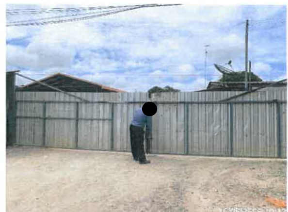
รูปที่ 2-1 แสดงรั้ว Metal Sheet โดยรอบพื้นที่ก่อสร้าง
