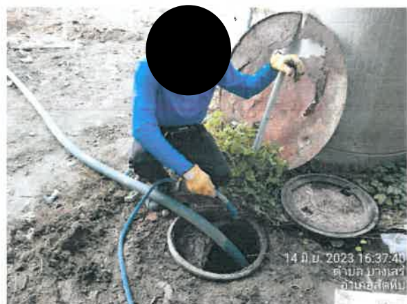
รูปที่ 2-22 แสดงห้องส้วมที่มีระบบบำบัดน้ำเสียสำเร็จรูปแบบถังเกรอะ-กรองไร้อากาศ และเจ้าหน้าที่สูบน้ำตะกอนบ่อเกรอะไปกำจัด
