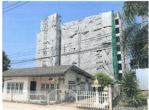
รูปที่ 2-10 แสดงติดตั้ง Mesh Sheet คลุมอาคาร B
