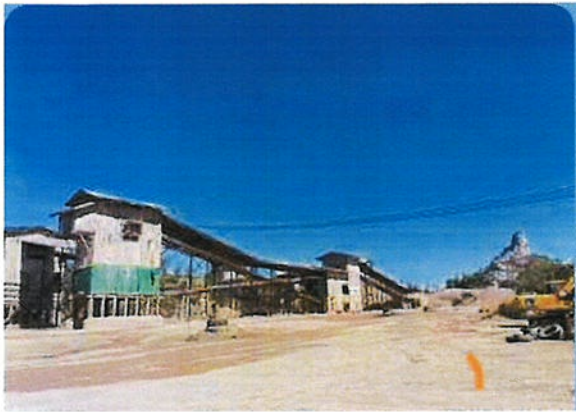
รูปที่ 6 การปิดคลุมอาคารโรงโม่หิน
