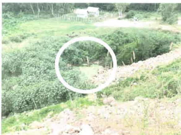
รูปที่ 21 บ่อดักตะกอนดินรองรับน้ำขุ่นข้นที่เกิดจาก การชะล้างบริเวณที่เก็บกองแร่
