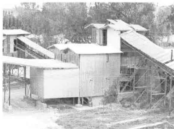
รูปที่ 16 การปิดคลุมอาคารโรงโม่หิน ชุด Hopper และ Primary Crusher
