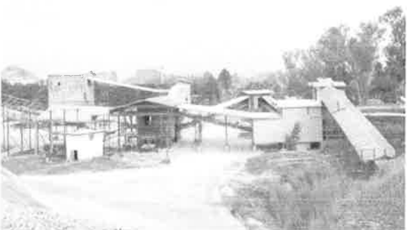
รูปที่ 15 การปิดคลุมอาคารโรงโม่หิน
