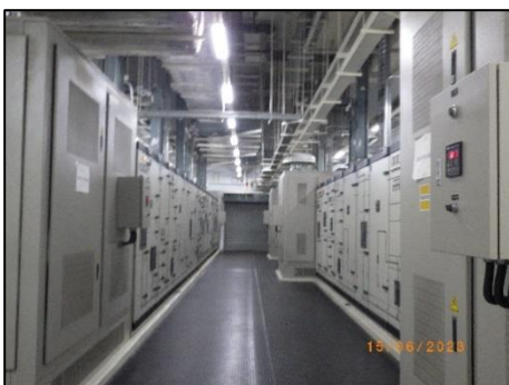
รูปที่ 2-21 การติดตั้งอุปกรณ์ปรับแรงดันไฟฟ้า
