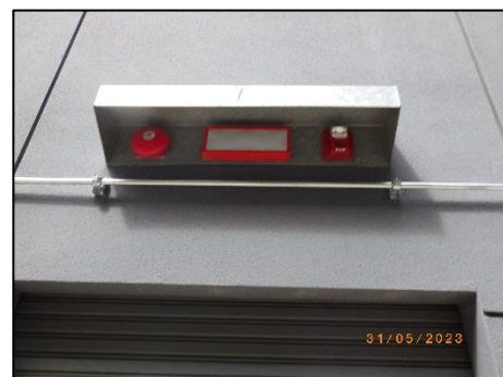
กริ่งดับเพลิงและไฟสำรองฉุกเฉิน
