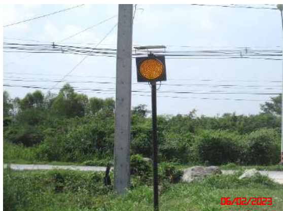
รูปที่ 14 สัญญาณไฟกระพริบและกระจกสะท้อนบริเวณเส้นทางขนส่งแร่
