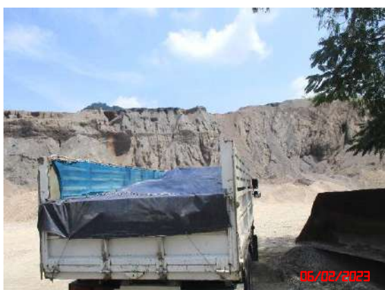
รูปที่ 21 การใช้ผ้าใบปิดคลุมกระบะรถบรรทุกพร้อมป้ายเตือน
