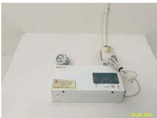
ไฟส่องสว่างฉุกเฉิน ภาพที่ 1.3.7-1 ระบบไฟฟ้า
