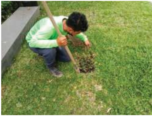
ตรวจสอบท่อระบายน้ำและขุดลอกตะกอนดิน ภาพที่ 2.2-7 (ต่อ) ระบบระบายน้ำและป้องกันน้ำท่วม
