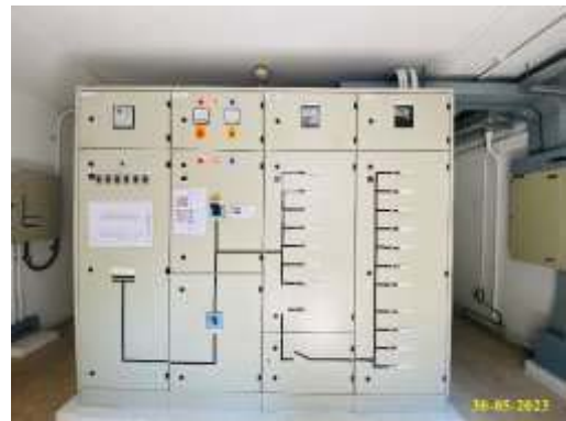
Main Distribution Board อาคาร B
