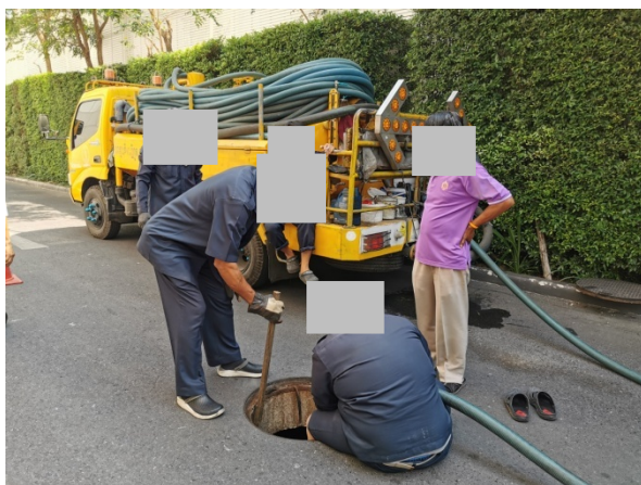
รูปที่ 2-12 การสูบน้ำออกจากระบบบำบัดน้ำเสีย
