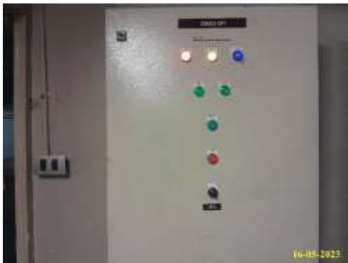
ตู้ควบคุมอัตโนมัติการระบายน้ำออกจากโครงการ
