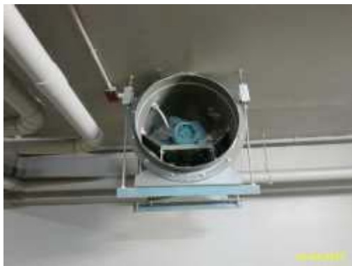
พัดลมระบายอากาศพื้นที่จอดรถ
