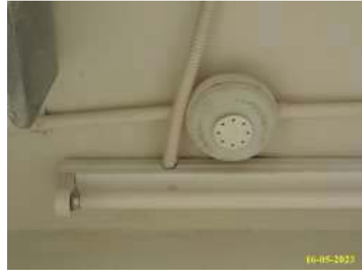
เครื่องตรวจจับความร้อน (Heat Detector; H)
