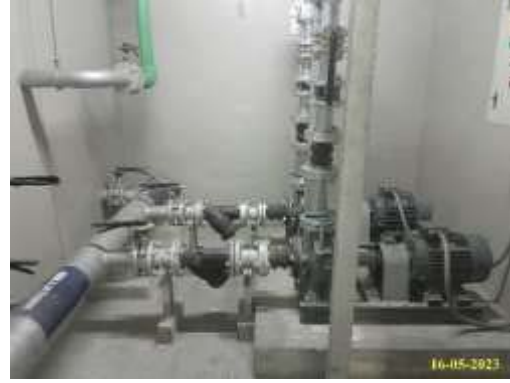
เครื่องสูบน้ำ (Packaged Booster Pump)
