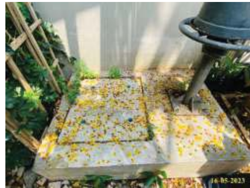
บ่อพักน้ำสุดท้ายก่อนระบายออกลงรางสาธารณะ
