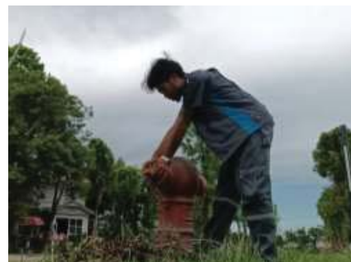
เจ้าหน้าที่ตรวจสอบหัวรับน้ำดับเพลิง ภาพที่ 2.2-10 ระบบการป้องกันอัคคีภัย
