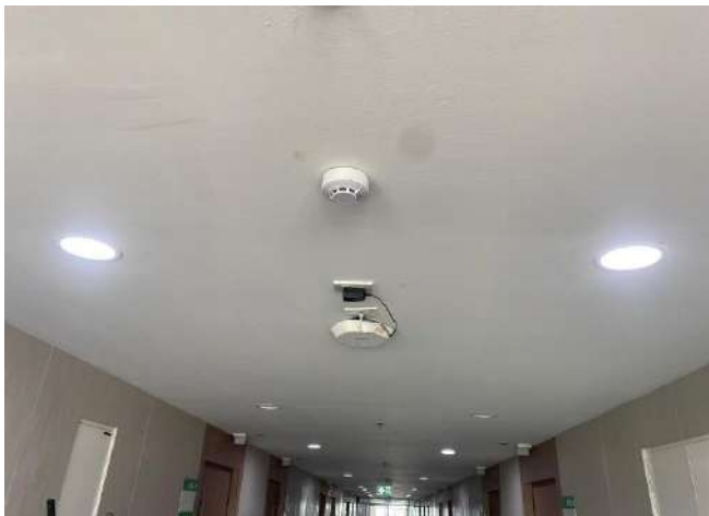
รูปที่ 17 อุปกรณ์แจ้งเหตุ เครื่องตรวจจับควัน (Smoke Detector)
