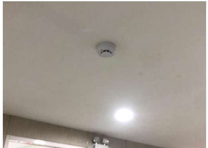
รูปที่ 17 อุปกรณ์แจ้งเหตุ เครื่องตรวจจับควัน (Smoke Detector)
