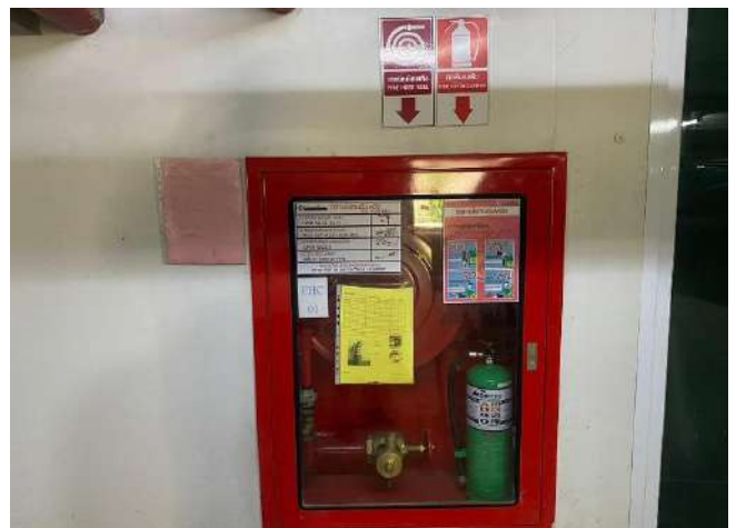
รูปที่ 20 ตู้สายฉีดน้ำดับเพลิง (Fire Hose Cabinet)
