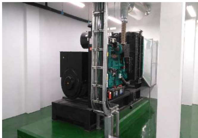
รูปที่ 13 เครื่องกำเนิดไฟฟ้าสำรอง
