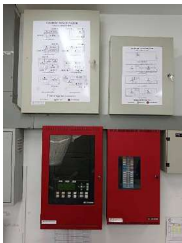
รูปที่ 16 ตู้ควบคุมระบบสัญญาณเตือนอัคคีภัย อุปกรณ์ส่งสัญญาณ แบบกริ่ง (Alarm Bell)
