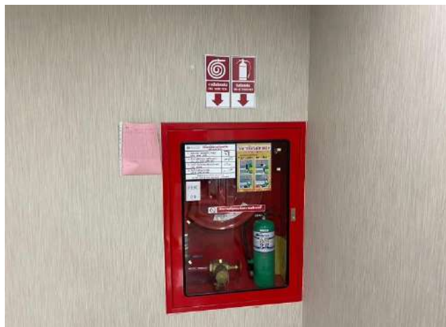
รูปที่ 20 ตู้สายฉีดน้ำดับเพลิง (Fire Hose Cabinet)
