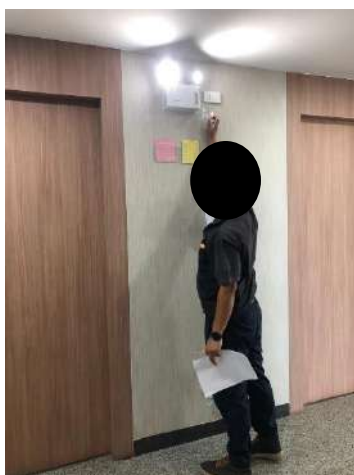
รูปที่ 21 การตรวจสอบไฟส่องสว่างฉุกเฉิน
