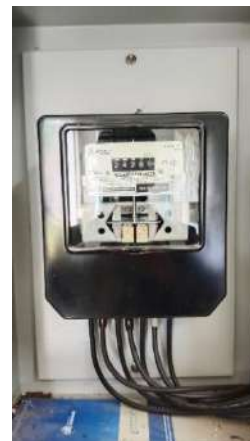
รูปที่ 5 การตรวจสอบมิเตอร์การใช้ไฟฟ้าของระบบบำบัดน้ำเสีย
