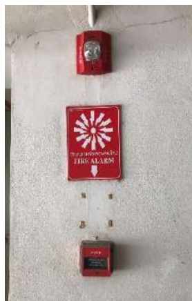
รูปที่ 16 ตู้ควบคุมระบบสัญญาณเตือนอัคคีภัย อุปกรณ์ส่งสัญญาณ แบบกริ่ง (Alarm Bell)
