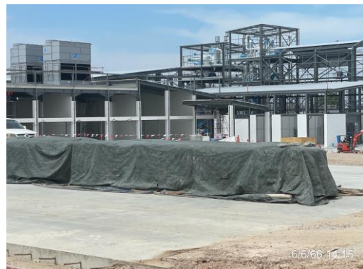
รูปที่ 5 การปิดคลุมกองวัสดุก่อสร้าง
