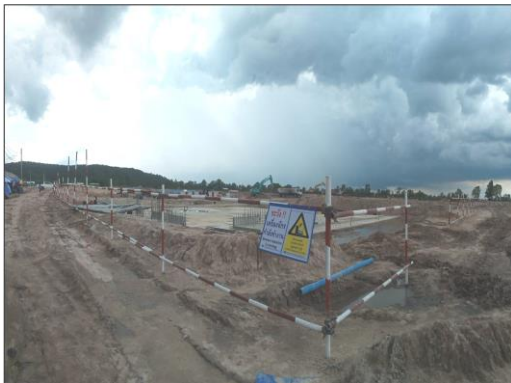
รูปที่ 2 การกั้นเขตพื้นที่ที่มีการขุด
