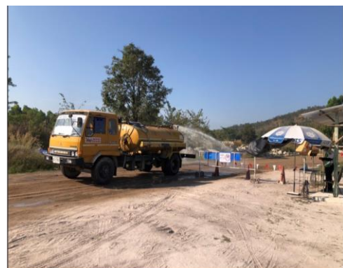
รูปที่ 6 การฉีดพรมน้ำในพื้นที่ก่อสร้าง
