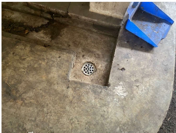
รูปที่ 2-17 ท่อรวบรวมน้ำบริเวณห้องพักมูลฝอยรวม
