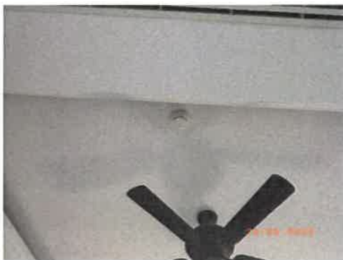
รูปที่ 2-24 เครื่องตรวจจับควันไฟภายในอาคาร
