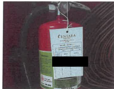
รูปที่ 2-29 ตัวอย่างการตรวจสอบสภาพถังดับเพลิง ประจำเดือน
