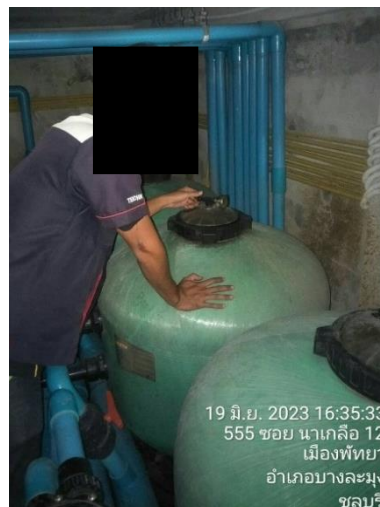
การทำความสะอาดเครื่องกรองสระว่ายน้ำ
