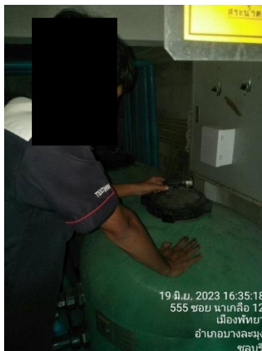
การทำความสะอาดเครื่องกรองสระว่ายน้ำ
