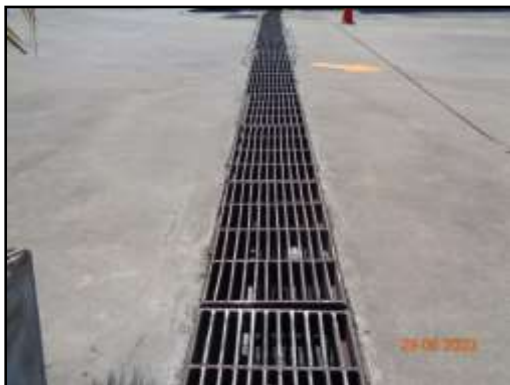
รูปที่ 2-23 รางระบายน้ำฝนรอบพื้นที่โครงการ
