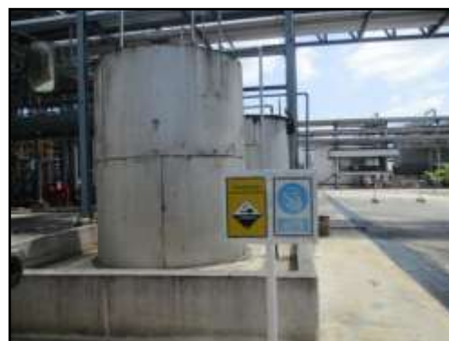
รูปที่ 2-51 ถังเก็บ NaOH
