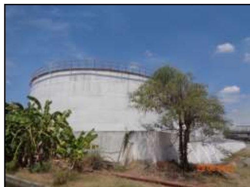
รูปที่ 2-41 คันคอนกรีตล้อมรอบถังเก็บเอทานอล
