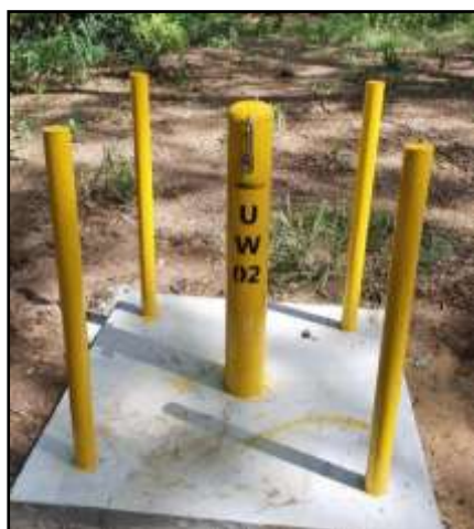
รูปที่ 2-27 บ่อสังเกตการณ์ (Monitoring Well) บริเวณพื้นที่โครงการ
