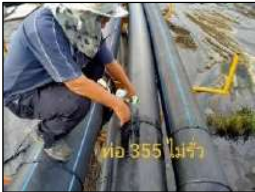
รูปที่ 2-26 การตรวจสอบสภาพของพลาสติก HDPE คลุมบ่ออย่างสม่ำเสมอ
