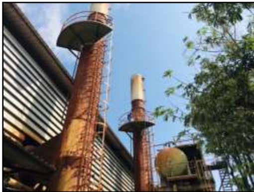
รูปที่ 2-1 ปล่องระบายอากาศของหม้อน้ำ ขนาด 20 ตัน
