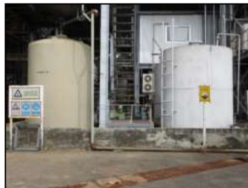
รูปที่ 2-52 ถังเก็บ H_2SO_4
