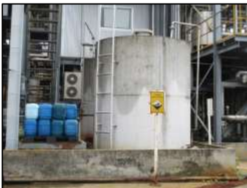
รูปที่ 2-52 ถังเก็บ H_2SO_4
