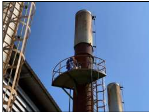
รูปที่ 2-1 ปล่องระบายอากาศของหม้อน้ำ ขนาด 20 ตัน
