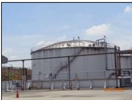
รูปที่ 2-41 คันคอนกรีตล้อมรอบถังเก็บเอทานอล
