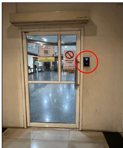
ภาพที่ 2-14 เครื่อง scan นิ้วมือที่ประตูทางเชื่อมระหว่าง Plaza และอาคาร B
