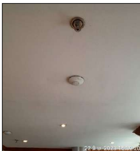
ภาพที่ 2-16 (ต่อ) อุปกรณ์ป้องกันอัคคีภัยและป้ายแนะนำการใช้อุปกรณ์
