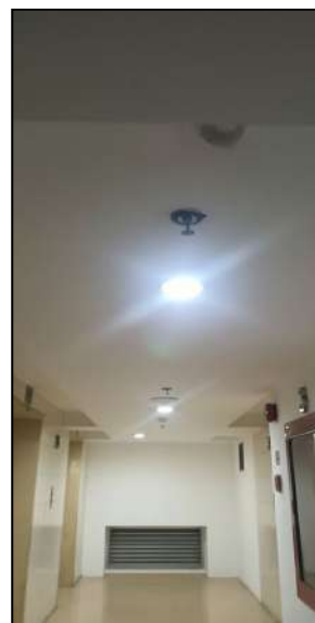
ภาพที่ 2-4 การเปลี่ยนมาใช้หลอดไฟ LED แทนหลอดตะเกียบ
