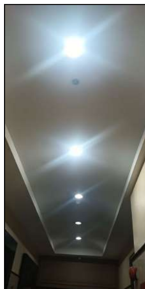
ภาพที่ 2-4 การเปลี่ยนมาใช้หลอดไฟ LED แทนหลอดตะเกียบ
