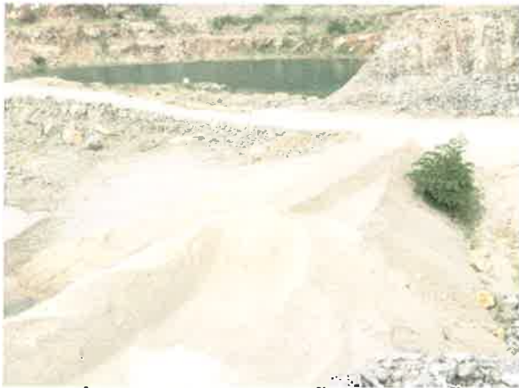
รูปที่ 7 นำเปลือกดินจากหน้าเหมืองมาสร้างคันทำนบดินและเตรียมปลูกไม้ยืนต้น
