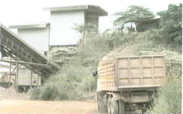
รูปที่ 15 การปิดคลุมอาคารโรงโม่หิน ชุด Hopper & Primary Crusher
