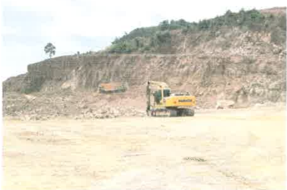
รูปที่ 3 ระหว่างแนวเส้นทางที่ต้องตัดขึ้นสู่ยอดเขาทยอยเปิดหน้างานบางส่วนให้เป็นชั้นบันได
