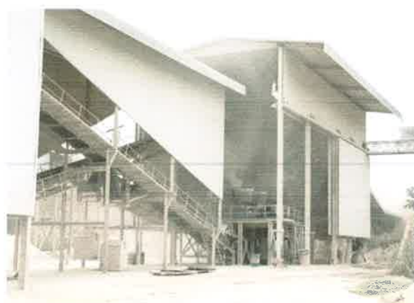
รูปที่ 17 การปิดคลุมอาคารโรงโม่หิน ชุด Secondary & Tertiary Crusher
