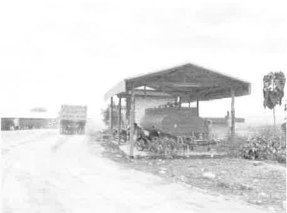
รูปที่ 21 ถังเก็บน้ำสำหรับสเปรย์น้ำในโรงโม่หิน
