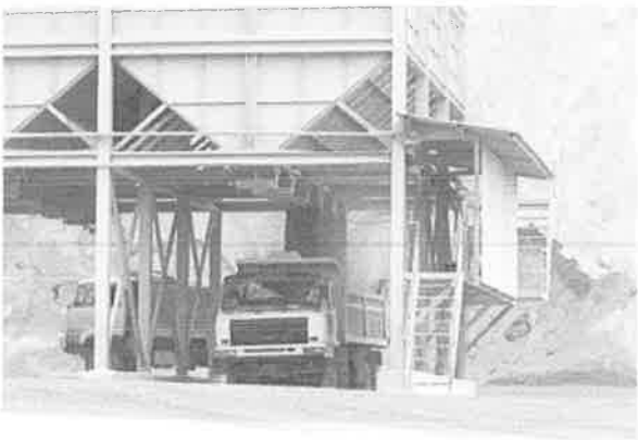
รูปที่ 20 การออกแบบยังเก็บหิน เพื่อลดการฟุ้งกระจายของฝุ่นหินจากปลายสายพาน
