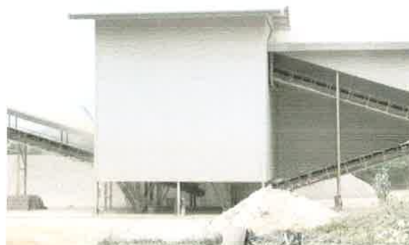
รูปที่ 18 การปิดคลุมอาคารโรงโม่หิน ชุด Product Screen
