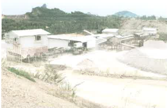
รูปที่ 13 การปิดคลุมอาคารโรงโม่หินทั้งโรงงาน
