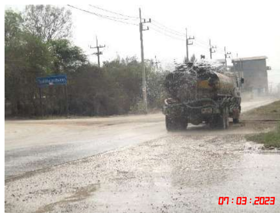
รูปที่ 16 การฉีดพรมน้ำบริเวณเส้นทางขนส่งลำเลียงแร่และบริเวณโรงโม่หิน
