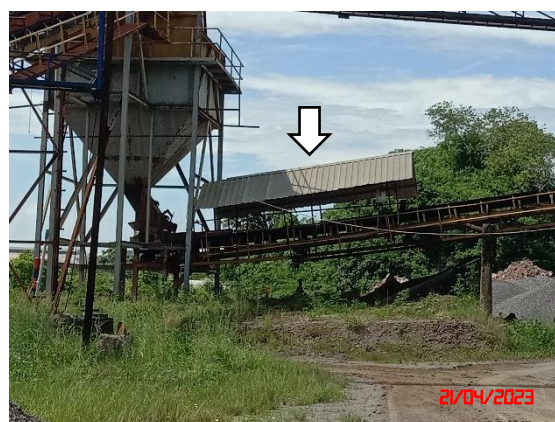
หลังคาปิดคลุมระบบสายพานลำเลียง
