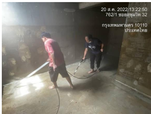
ภาพที่ 2-26 ล้างถังเก็บน้ำชั้นใต้ดินและดาดฟ้า
