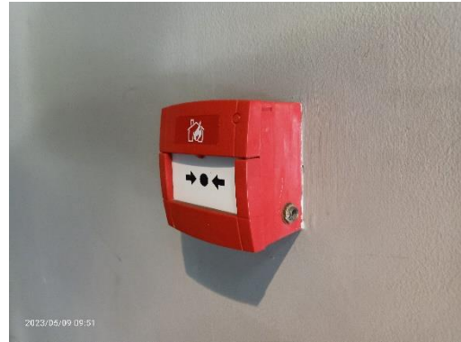
เครื่องแจ้งเหตุโดยใช้มือดึง และช่องเสียบบัตรคัท ฉุกเฉิน
