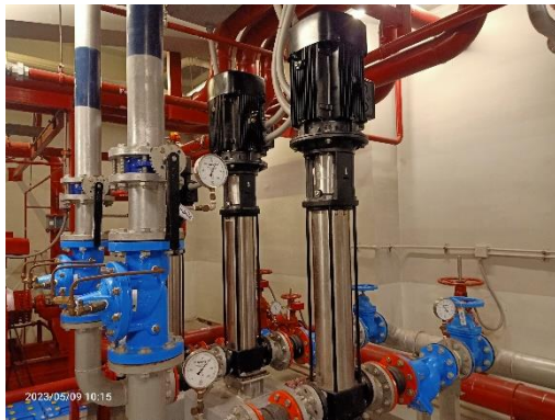
ถังเก็บน้ำชั้นใต้ดิน จำนวน 2 ถัง และปั๊มสูบน้ำขึ้น ถังเก็บน้ำชั้นดาดฟ้า
