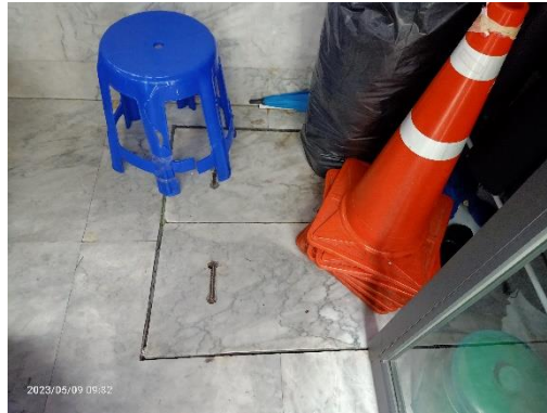
ภาพที่ 2-11 บ่อพักน้ำใส เพื่อติดตามตรวจสอบคุณภาพน้ำทิ้งภายหลังการบำบัด
