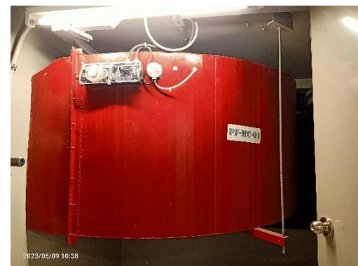
พัดลมอัดอากาศสำหรับบันไดหนีไฟทั้ง 4 ตัว
