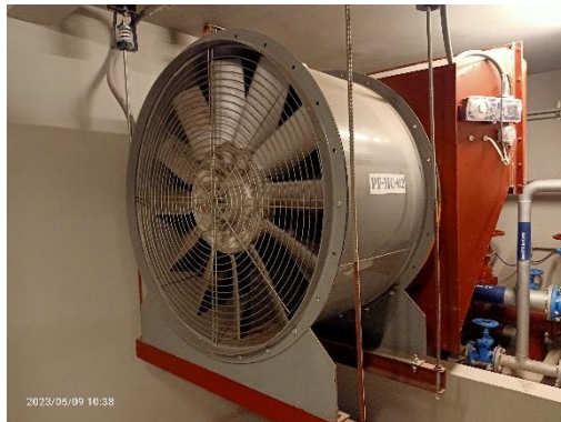
พัดลมอัดอากาศสำหรับบันไดหนีไฟทั้ง 4 ตัว
