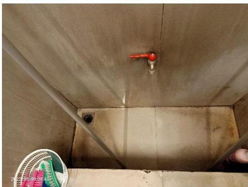
ท่อรวบรวมน้ำเสียที่เกิดจากการล้างห้องพักมูลฝอยรวม
