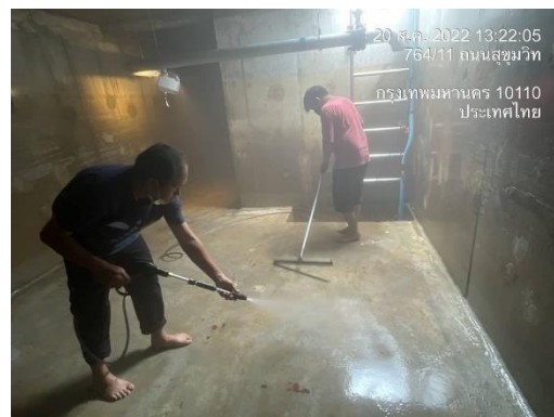
ภาพที่ 2-26 ล้างถังเก็บน้ำชั้นใต้ดินและดาดฟ้า
