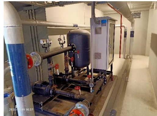
บูสเตอร์ปั๊มควบคุมแรงดันน้ำ (ชั้นดาดฟ้า)
