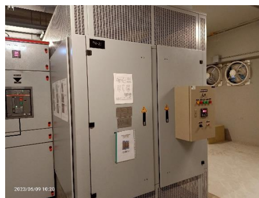
Transformer ชนิด Dry type ขนาด 1,600 KVA จำนวน 2 ชุด
