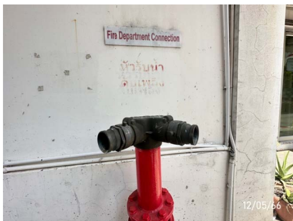
หัวรับน้ำดับเพลิง (Fire Department Connector : FDC)
