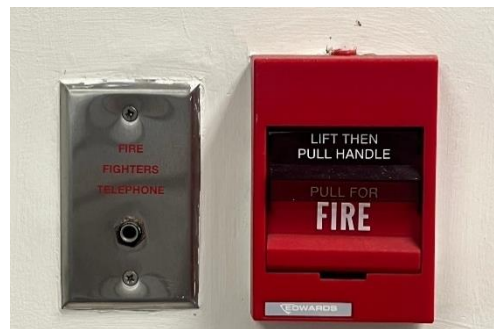
Telephone Jack และ Manual Station
