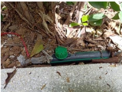
ระบบการนำน้ำเสียที่ผ่านการบำบัดมารดน้ำต้นไม้
