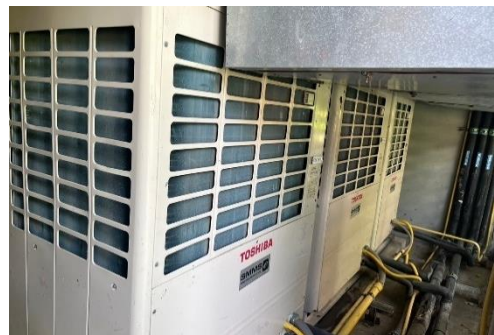
เครื่องปรับอากาศแบบ VRF
