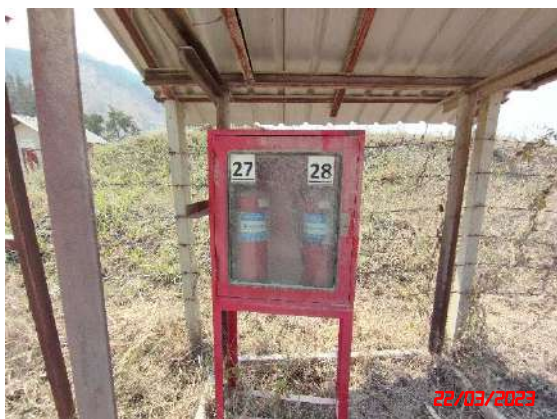
รูปที่ 11 จุดติดตั้งอุปกรณ์ดับเพลิง
