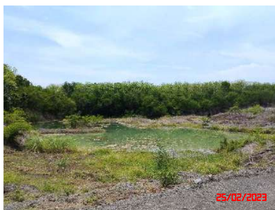
รูปที่ 11 บ่อดักตะกอนของโครงการ
