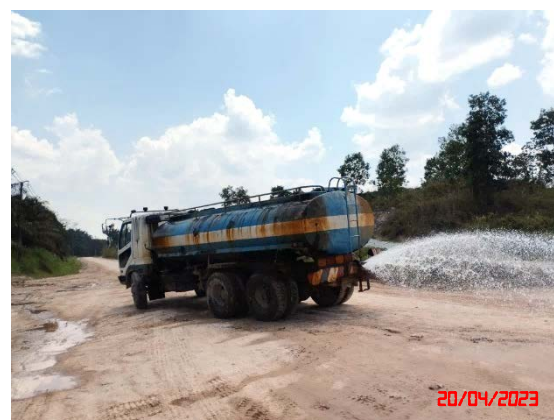
รูปที่ 14 การฉีดพรมน้ำในพื้นที่โครงการ
