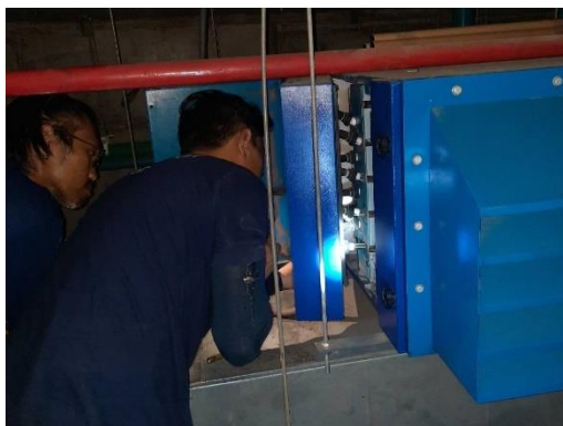
ตรวจสอบระบบ UV ที่ดูดอากาศจากระบบบำบัดน้ำเสีย
