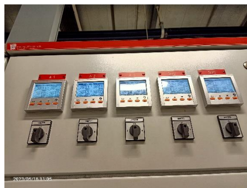
มิเตอร์ไฟฟ้าแยกเฉพาะระบบบำบัดน้ำเสีย
