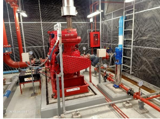
Fire Pump & Jockey Pump ชั้น11 M
