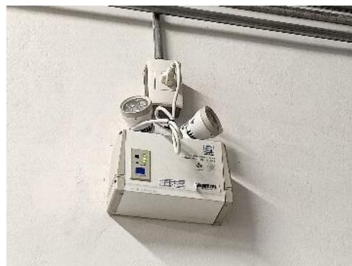
ไฟฉุกเฉินในห้องหม้อแปลงไฟฟ้า
