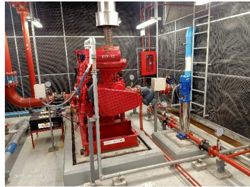
Fire Pump & Jockey Pump ชั้น 11 M
