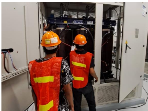
เจ้าหน้าที่ตรวจสอบหม้อแปลงไฟฟ้า
