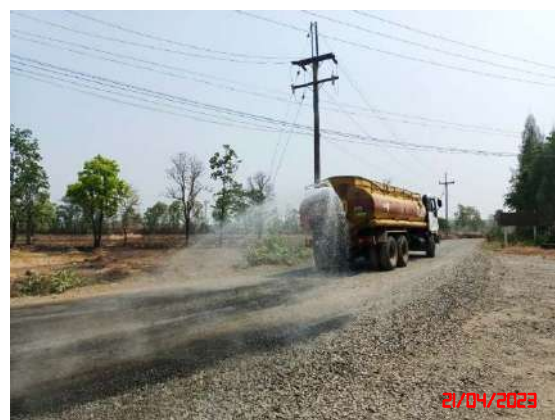
รูปที่ 24 การฉีดพรมน้ำเส้นทางขนส่งแร่
