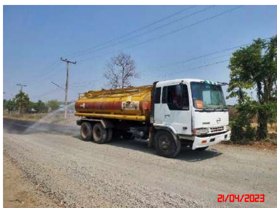
รูปที่ 24 การฉีดพรมน้ำเส้นทางขนส่งแร่
