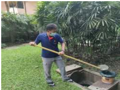
การตัดไขมันออกจากระบบบำบัดน้ำเสีย
