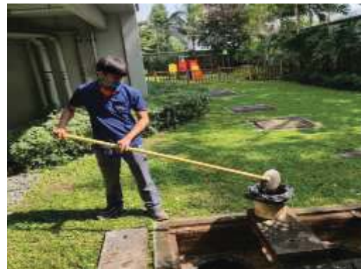
การตัดไขมันออกจากระบบบำบัดน้ำเสีย
