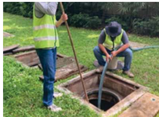
การตัดไขมันออกจากระบบบำบัดน้ำเสีย
