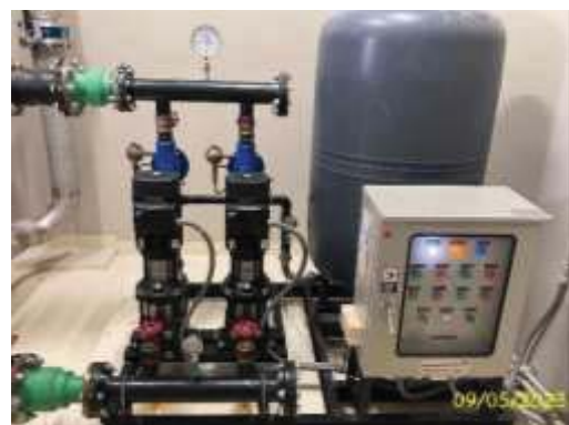
ระบบจ่ายน้ำขึ้นหลังคาอาคาร B
