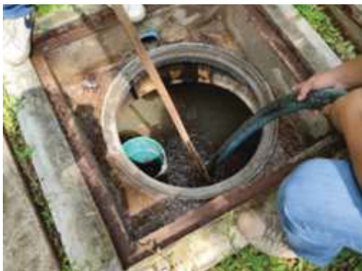
การตัดไขมันออกจากระบบบำบัดน้ำเสีย
