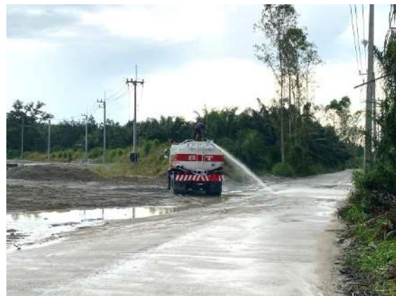
รูปที่ 12 การฉีดพรมน้ำบริเวณลานเก็บกองแร่ เส้นทางขนส่งแร่ และบริเวณพื้นที่โครงการ
