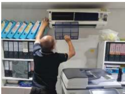
ทำความสะอาดแผ่นกรอกอากาศ
