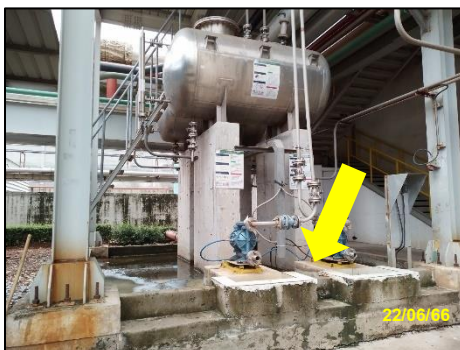
รูปที่ 2-39 เชื้อนป้องกันการรั่วไหลรอบถังบรรจุมะพร้าว
