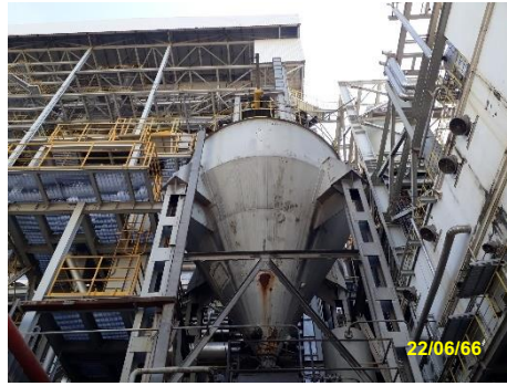
รูปที่ 2-29 ถังเก็บเถ้าหนัก (Bottom Ash Silo)
