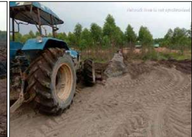
ไถกระจายพื้นที่เพื่อป้องกันการฟุ้งกระจาย
