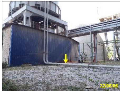
รูปที่ 2-7 ระบบลำเลียงเถ้าจากหน่วยการผลิตเข้าสู่ไซโล
