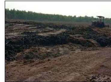
ไถกระจายพื้นที่เพื่อป้องกันการฟุ้งกระจาย
