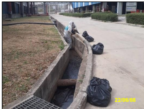
รูปที่ 2-18 การขุดลอกตะกอนรางระบายน้ำ
