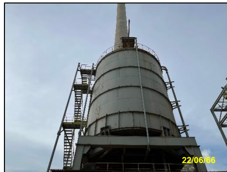
รูปที่ 2-28 ถังเก็บเถ้าลอย (Fly Ash Silo)
