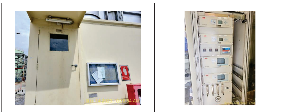
ภาพที่ 3.2-1 : ระบบการตรวจวัดคุณภาพอากาศจากปล่องอย่างต่อเนื่อง (CEMS) ของโครงการ
