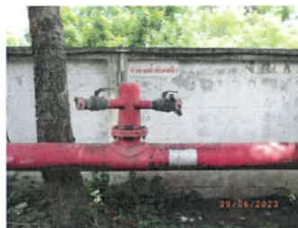
รูปที่ 2-44 หัวรับน้ำดับเพลิงและหัวจ่ายน้ำดับเพลิง
