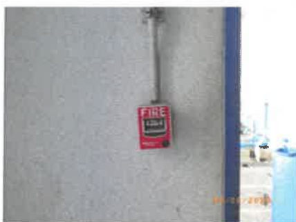
รูปที่ 2-38 ระบบสัญญาณเตือนภัย
