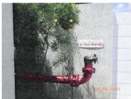
รูปที่ 2-44 หัวรับน้ำดับเพลิงและหัวจ่ายน้ำดับเพลิง
