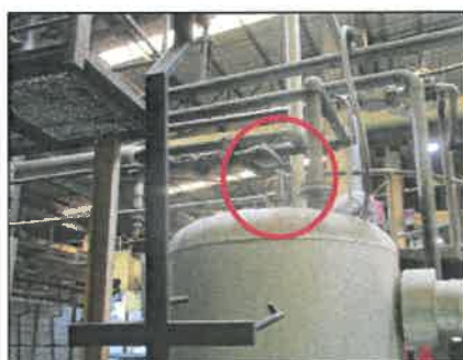
รูปที่ 2-45 อุปกรณ์นิรภัยบริเวณหม้อน้ำ (Safety Valve)
