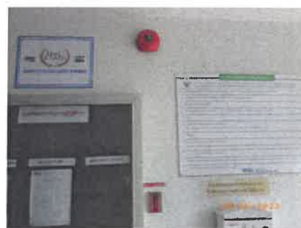
รูปที่ 2-38 ระบบสัญญาณเตือนภัย
