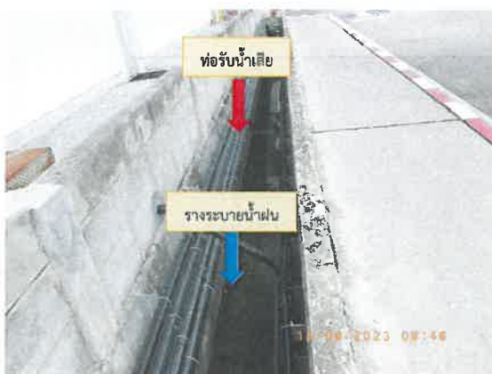
รูปที่ 2-27 ระบบระบายน้ำเสียที่แยกออกจาก รางระบายน้ำฝน
