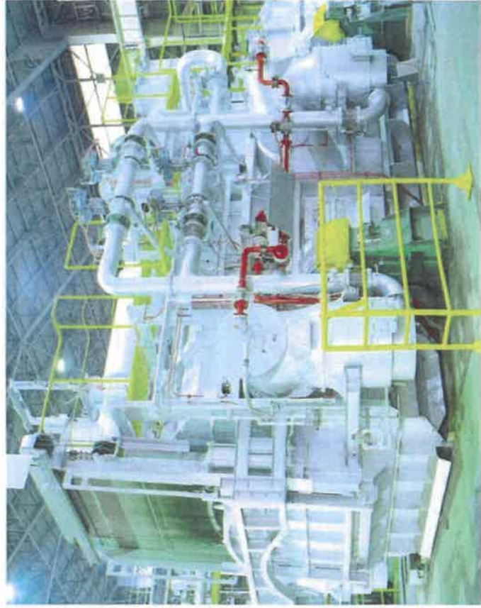
アルミ溶融炉に設置したRSH型低NOxリジエネレイティブバーナ RSH Type Regenerative Low NOx Burner installed in aluminum melting furnace
