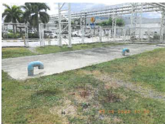
รูปที่ 2-19 บ่อพักน้ำทิ้งฉุกเฉิน
