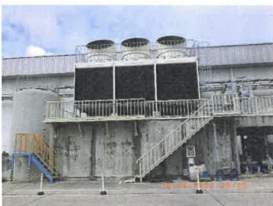
รูปที่ 2-16 ถังพักน้ำหมุนเวียนจากระบบหล่อเย็น ของกระบวนการอื่นๆ
