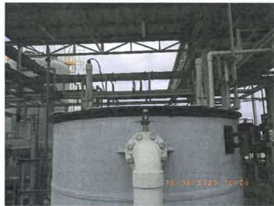
รูปที่ 2-13 ถังพักน้ำทิ้งจากระบบผลิตน้ำ RO (Ro Brine)
