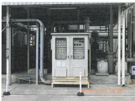
รูปที่ 2-5 ระบบบำบัดมลพิษทางอากาศ แบบระบบหอดูดซึม (Spray Tower)
