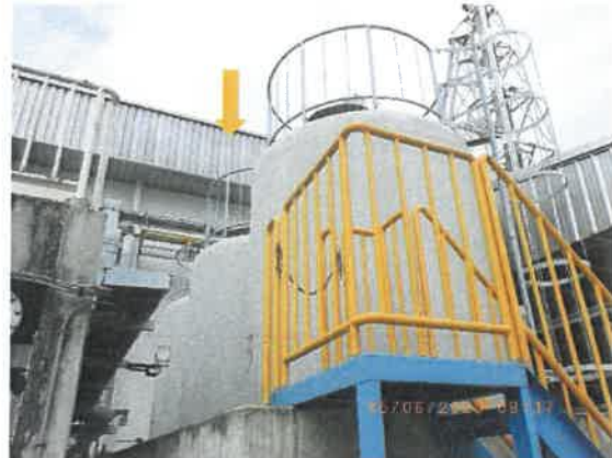
รูปที่ 2-8 บ่อพักน้ำทิ้งฉุกเฉินบริเวณระบบหอดูดซึม
