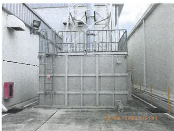
รูปที่ 2-10 ถังพักน้ำทิ้งจากเตาอบละลาย
