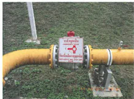
รูปที่ 2-46 ระบบท่อ Bypass และระบบวาล์วสำรอง
