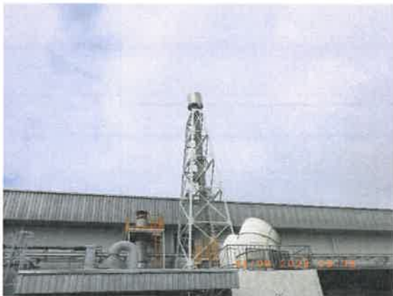
รูปที่ 2-2 ปล่องระบายจากระบบหอดูดซึม (Exhaust Gas Treatment System)
