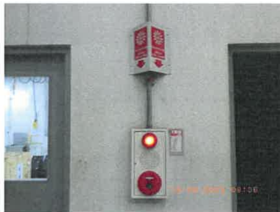
รูปที่ 2-40 สัญญาณเตือนภัยแบบอัตโนมัติ
