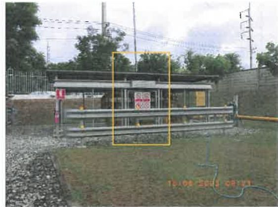
รูปที่ 2-44 ร้วตาข่ายโดยรอบสถานีควบคุม และมีประตูเข้า-ออก 2 ชั้น
