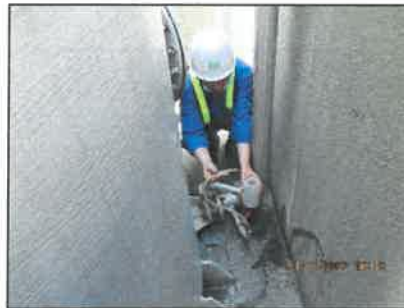
รูปที่ 3-11 แสดงการเก็บตัวอย่างคุณภาพน้ำทิ้งในถังพักน้ำทิ้ง จากระบบหอดูดซึมของโครงการฯ ในระยะดำเนินการ
