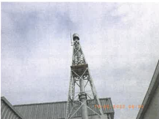
รูปที่ 2-4 ปล่องเตาอบละลาย (Solution Treatment Furnace)
