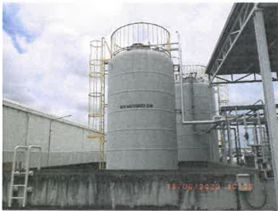
รูปที่ 2-12 ถังพักน้ำทิ้งจากการล้างย้อนระบบกรอง (Back wash waste Tank)
