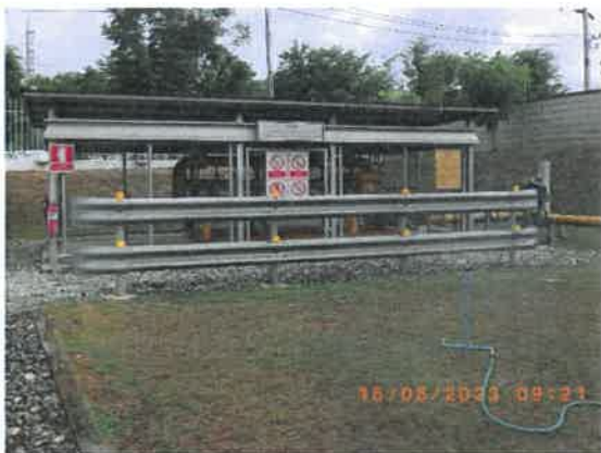
รูปที่ 2-45 สถานีควบคุมก๊าซและแนวท่อก๊าซ
