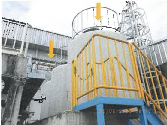
รูปที่ 2-7 บ่อพักน้ำบริเวณระบบหอดูดซึม
