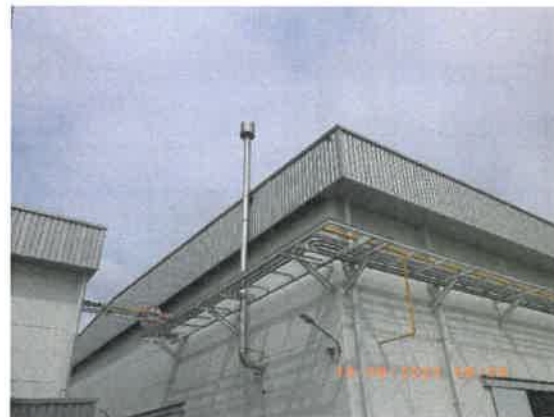
รูปที่ 2-3 ปล่องเตาอบอ่อน (Annealing Furnace)
