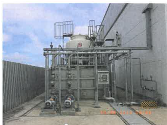
รูปที่ 2-17 ถังพักน้ำหมุนเวียนจากระบบหล่อเย็น ของหน่วยยัดและม้วน (A8#2)
