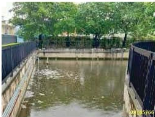
บ่อพักน้ำ ชุดท้ายก่อนระบายออกนอกโครงการพร้อมเครื่องเติมอากาศ
