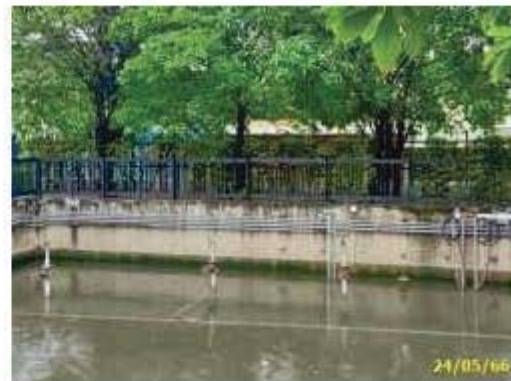
บ่อพักน้ำ ชุดท้ายก่อนระบายออกนอกโครงการพร้อมเครื่องเติมอากาศ
