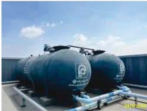
ถังเก็บน้ำชั้นตาดฟ้า พร้อมเครื่องปั๊มน้ำ
