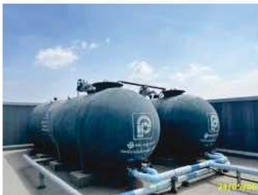
ถังเก็บน้ำขึ้นตามตึก พร้อมเครื่องปั๊มน้ำ
