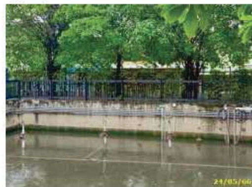
บ่อพักน้ำ พร้อมเครื่องเติมอากาศ
