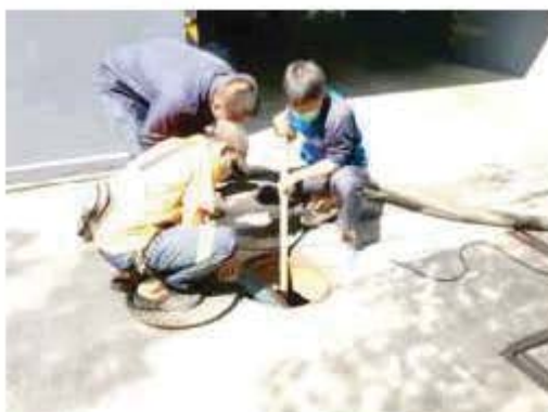
สูบตะกอนระบบบำบัดน้ำเสีย (12/02/66)
