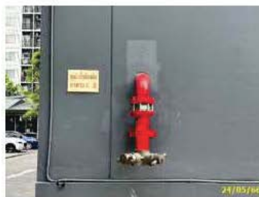
หัวรับน้ำดับเพลิงด้านหน้าอาคารชุดพักอาศัย
