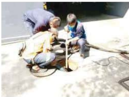
สูบลตะกอนระบบบำบัดน้ำเสีย (12/02/66)
