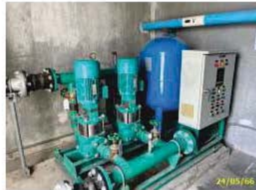
ถังเก็บน้ำชั้นตาดฟ้า พร้อมเครื่องปั๊มน้ำ
