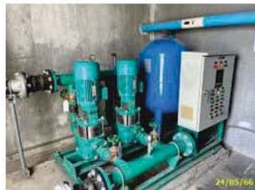
ถังเก็บน้ำขึ้นตามตึก พร้อมเครื่องปั๊มน้ำ
