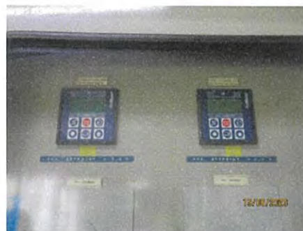
ภาพที่ 2.2-15 เครื่องตรวจวัดคุณภาพน้ำอัตโนมัติ (pH)
