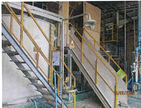
ภาพที่ 2.2-37 อ่างล้างตาและฝักบัวฉุกเฉิน
