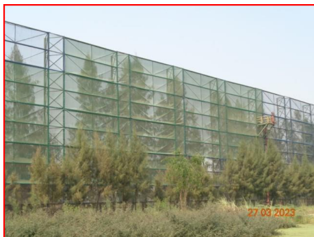
ภาพที่ 2.2-11 โครงสร้างเหล็กติดตาข่ายล้อมรอบพื้นที่ลานกองขานอ้อย
