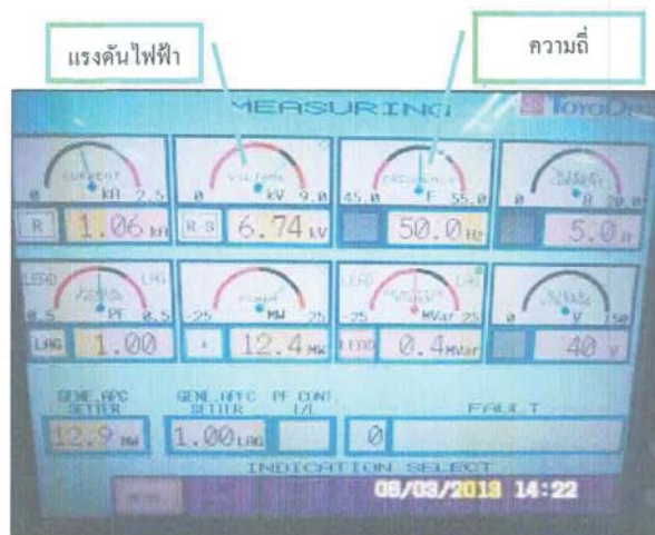
รูปที่ 5 แสดงหน้าจอแรงดันไฟฟ้าและความถี่ทางไฟฟ้าที่จอสัมผัส
