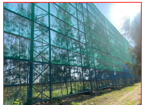
ภาพที่ 2.2-11 โครงสร้างเหล็กติดตาข่ายล้อมรอบพื้นที่ลานกองขานอ้อย
