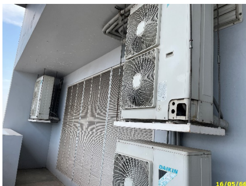
ระบบปรับอากาศเป็นแบบแยกส่วน (Air Cooled Split Type)
