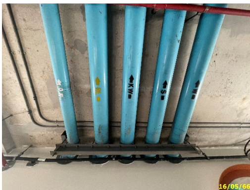
ระบบระบายน้ำฝนจากหลังคา
