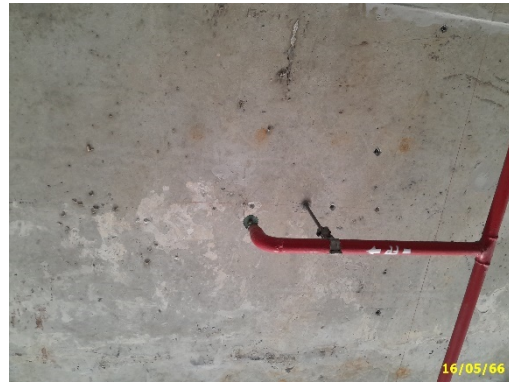
ระบบกระจายน้ำดับเพลิง
