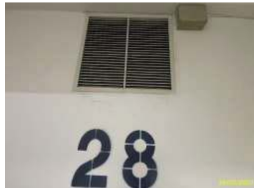
ช่องอัดอากาศบริเวณโถงลิฟต์
