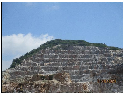
รูปที่ 2-13 การทำเหมืองแบบขั้นบันได
