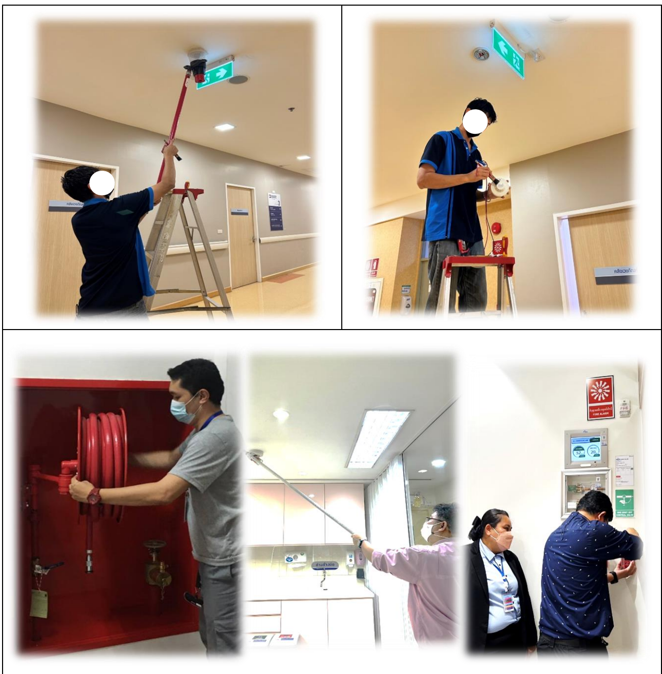
รูปที่ 3-4 การตรวจสอบระบบป้องกันอัคคีภัยของโครงการ
