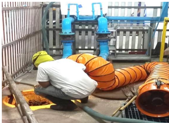
รูปที่ 2-9 การสูบน้ำจากระบบบำบัดน้ำเสียไปกำจัด
