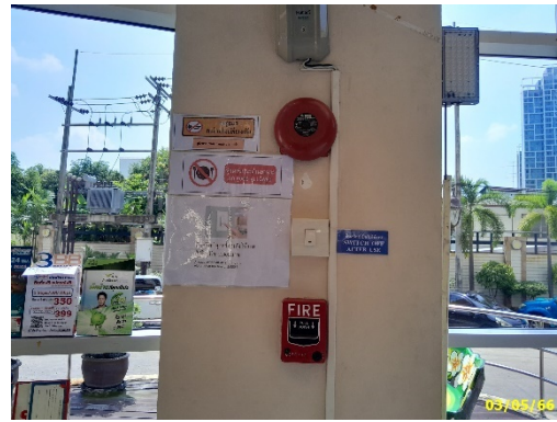
อุปกรณ์ส่งสัญญาณเตือนภัย และเครื่องแจ้งเหตุ โดยใช้มือดึงพร้อมช่องเสียบกุญแจ
