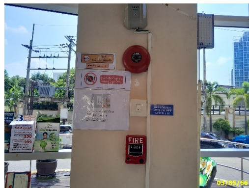
อุปกรณ์ส่งสัญญาณเตือนภัย และเครื่องแจ้งเหตุ โดยใช้มือดึงพร้อมช่องเสียบบุกกุญแจ
