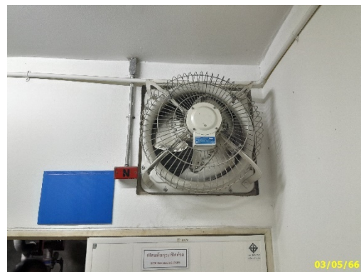
พัดลมระบายอากาศห้องเครื่องปั้มน้ำ
