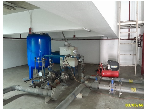
Booster pump ชั้นดาดฟ้า
