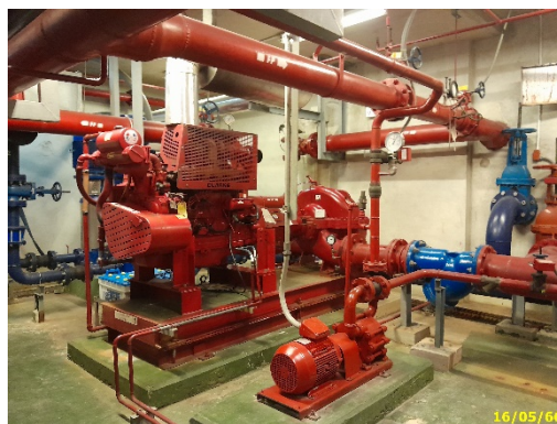
เครื่องสูบน้ำเพื่อการดับเพลิง
