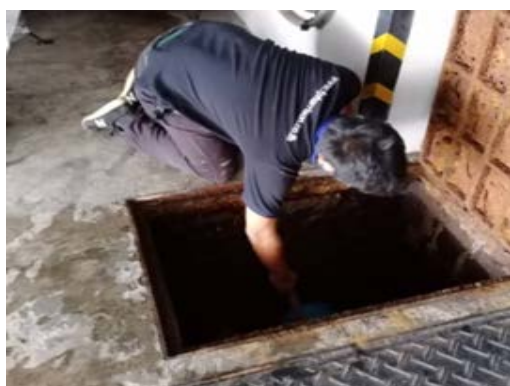
ตัดไขมันจากบ่อดักไขมัน (ครั้งล่าสุด)
