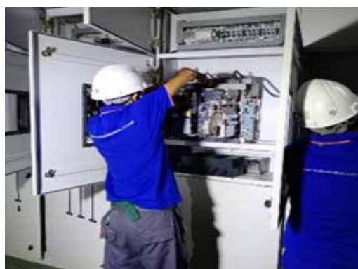
ตรวจเช็คระบบไฟฟ้าภายในอาคารประจำปี
